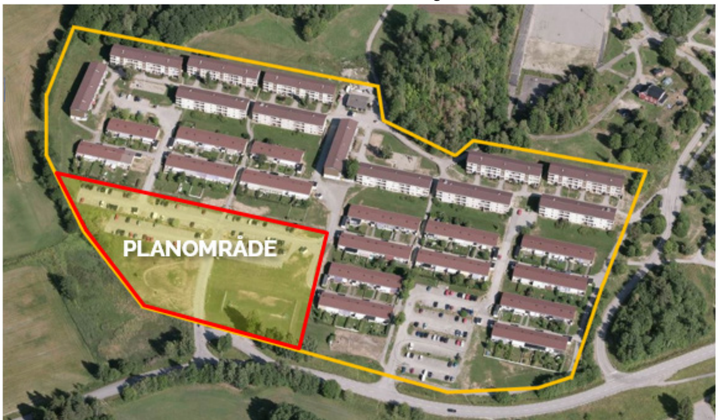
Foto över fastigheten mot öster
