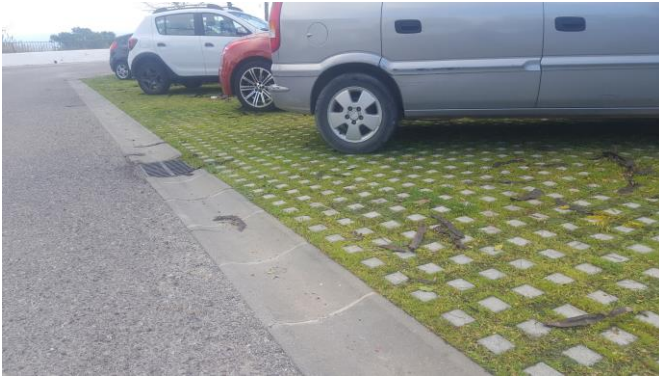
Figur 16: Bilparkering med armerat gräs som beläggning.
