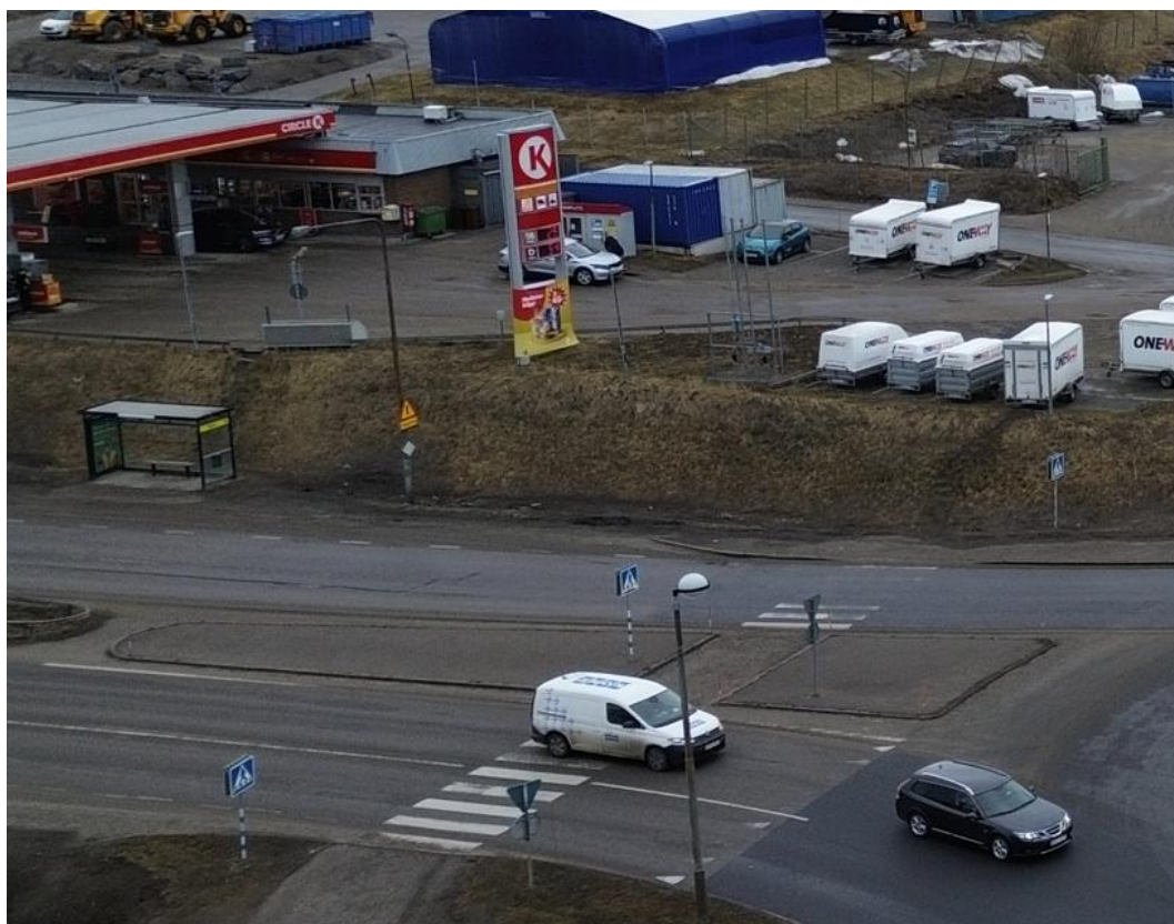
Figur 7 Bild som visar västergående hållplatsläge på Johannedalsvägen som saknar gångyta fram till hållplats.
