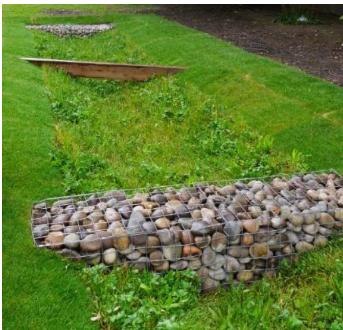
Figur 11. Svackdike med dämmande sektioner (Boverket, 2019)
