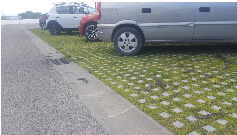
Figur 16. Bilden visar en bilparkering med armerat gräs som beläggning.
